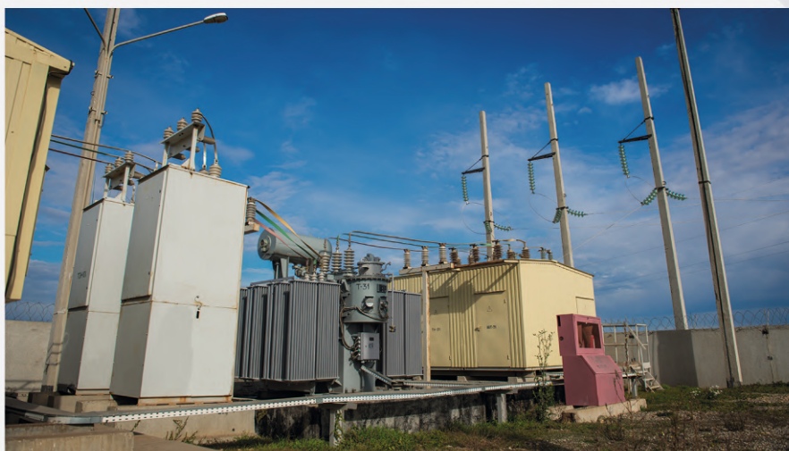
ООО СХП «Агроинвест» Реконструкция питающего центра ПС 35 – 10 Кв.
